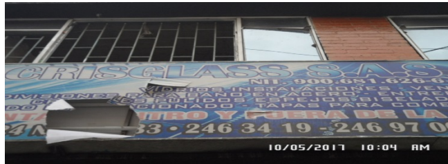
Fotografía No 2. Vista nombre comercial en fachada de la industria CRISGLASS S.A.S.
